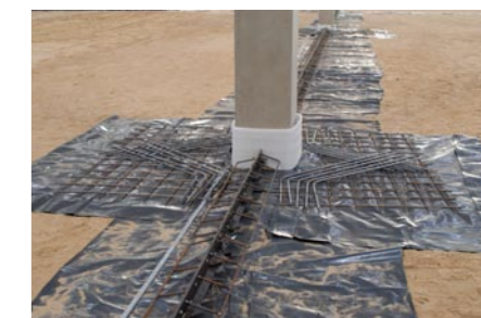
Fot. 3. Profile stalowe i dozbrojenie słupów prętami i siatkami
